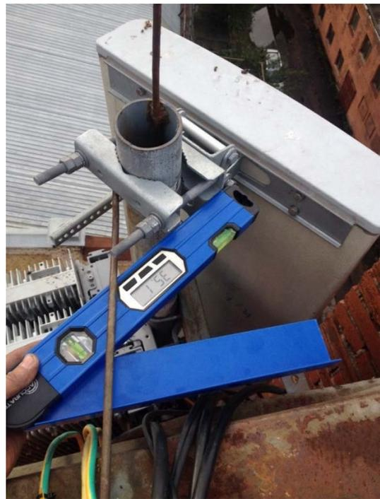
Рис. 3. Определение азимута с помощью прибора
