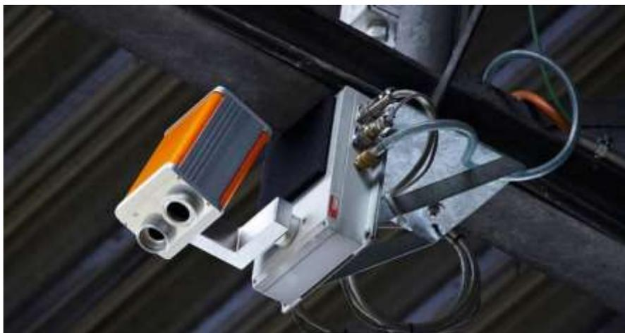
Рис. 2. Система обнаружения возгорания PYROsmart
